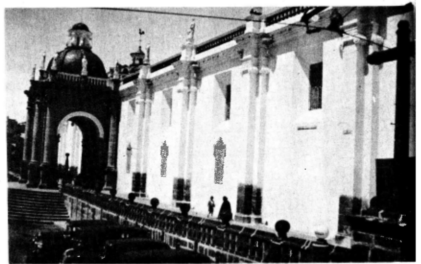
Catedral de Quito. Fachada que mira al Parque de la Independencia.
